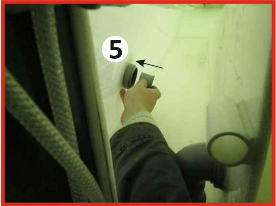
4. Отверстие самотёчного отвода (5) необходимо закрыть. Для этого снимаем заглушку (6) из впаянного патрубка (4) и вставляем её в отверстие (4), чтобы предотвратить попадание в него стока;
