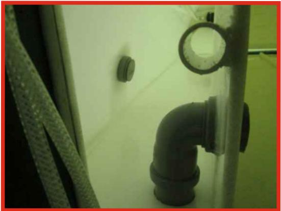
5. Ёмкость для принудительного отвода (7), нижней частью задней стенки, сверху-вниз вставляем в выступ (8), расположенный на основной перегородке со стороны приёмной камеры. Данный выступ припаивается в заводских условиях, с целью более надёжного крепления ёмкости (6);
